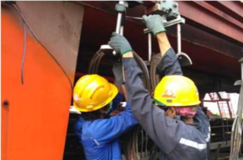
PEMASANGAN TROLLEY CABLE SR
