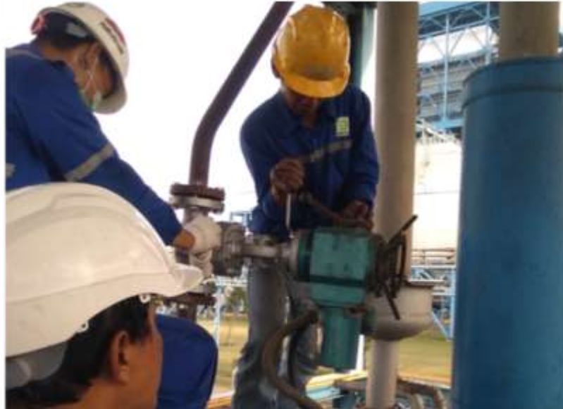
PEMASANGAN VALVE MOV SUB
